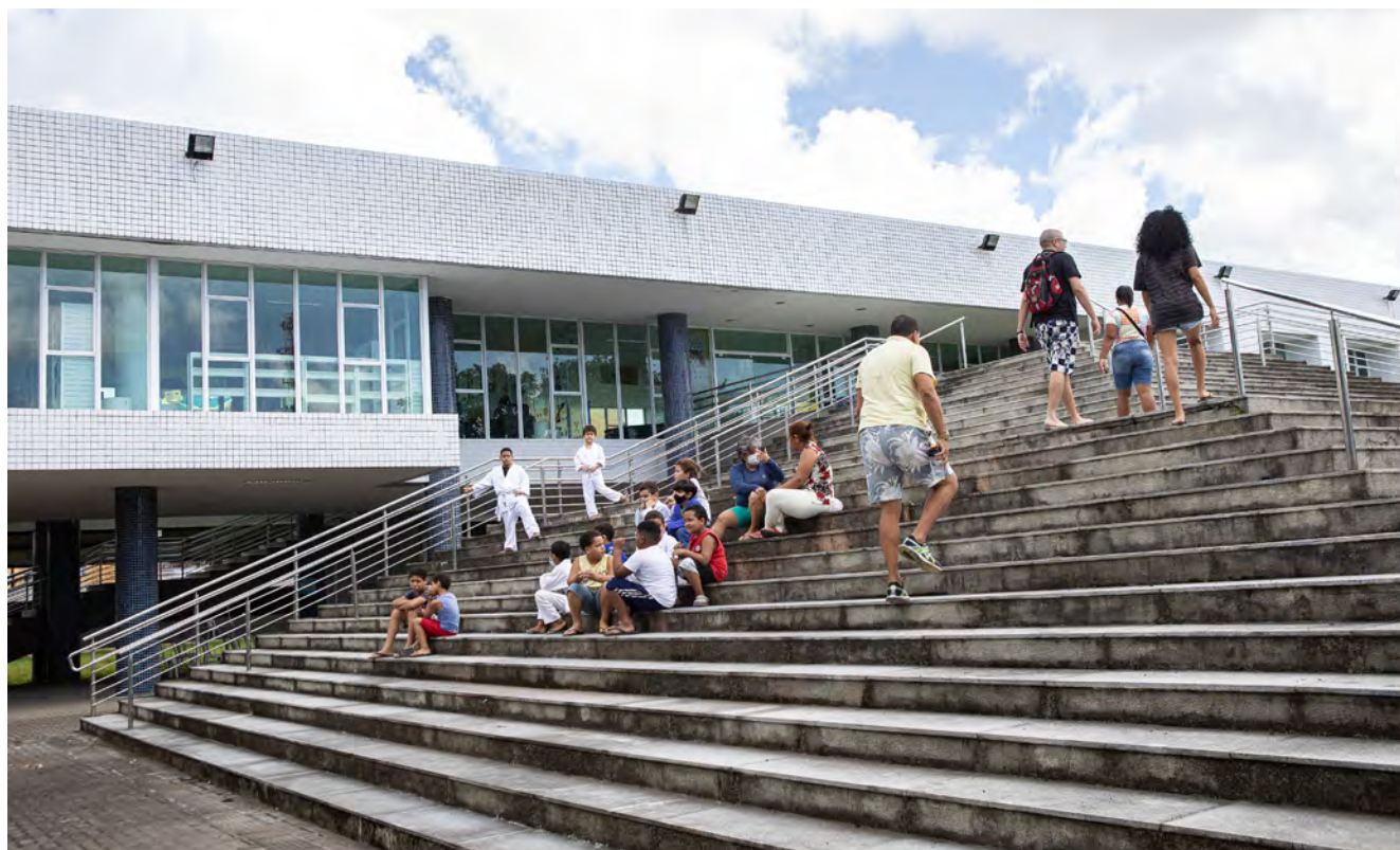
FIGURA 16 Escadaria monumental de acesso ao pavimento de serviços e à biblioteca. FONTE: Edson Holanda.
