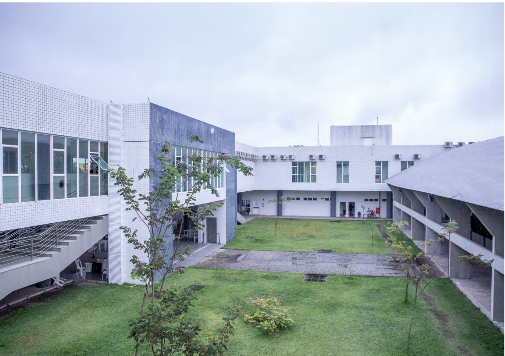
FIGURA 47 A estrutura em forma de U integra o edifício ao ginásio coberto. FONTE: Edson Holanda.
