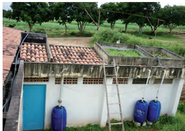
FIGURA 13 Instalações de estudo sobre telhados verdes.
