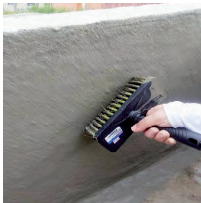
FIGURA 10 Impermeabilização da laje para implantação do telhado ecológico.
