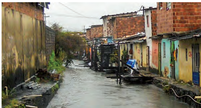
FIGURA 29 Canal do ABC: Habitações na calha do canal
