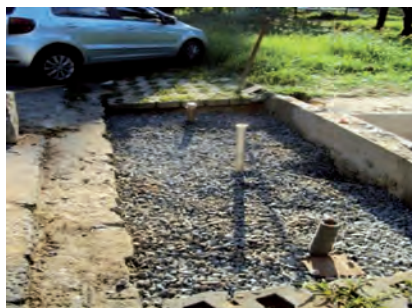
FIGURA 18 Etapas iniciais da construção do pavimento permeável na área de estacionamento da Escola de Engenharia de Pernambuco, CTG/UFPE Dissertação de mestrado de COUTINHO, 2011.
