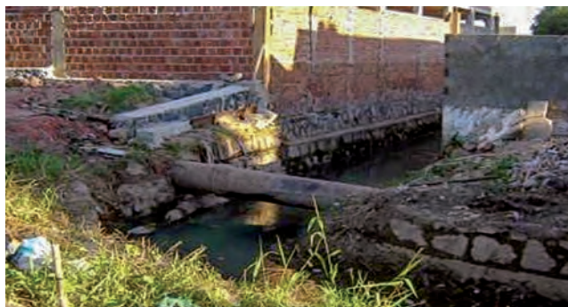
FIGURA 30 Curso de água obstruído por tubo da Compesa
