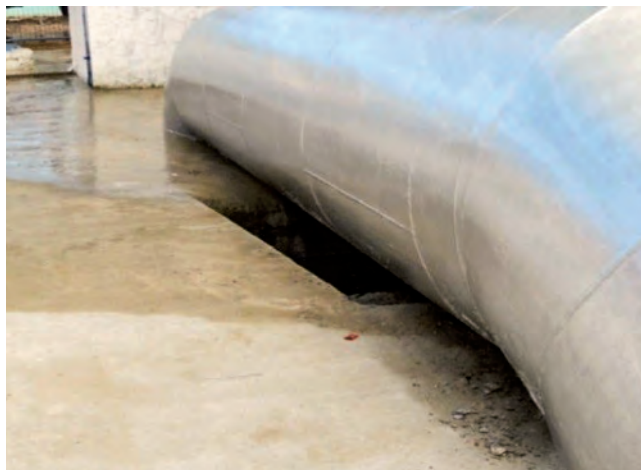
FIGURA 14 Tubulação da Compesa às margens do Canal Carneiro Mariz.
