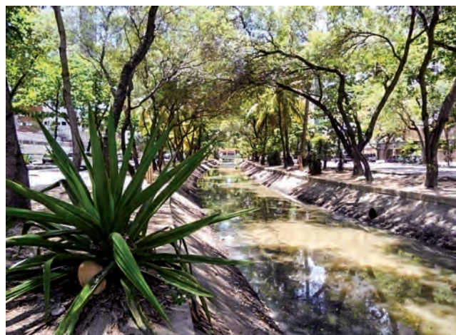
FIGURA 20 Canal do Setúbal já totalmente revestido
