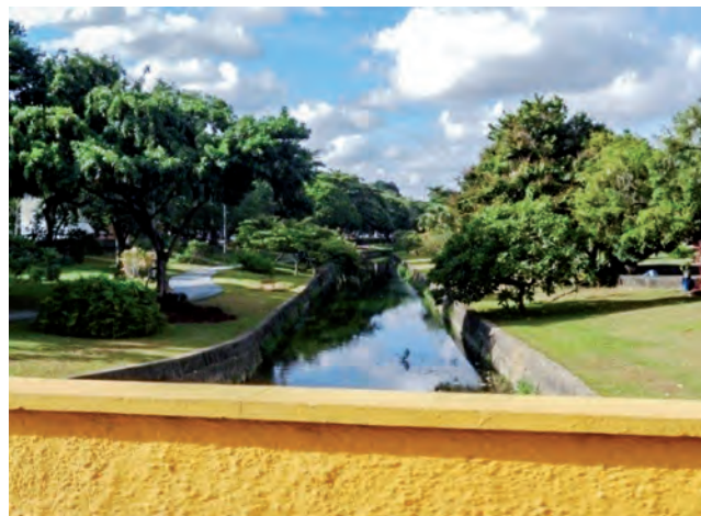
FIGURA 18 Tratamento das margens do Canal do Cavouco, UFPE
