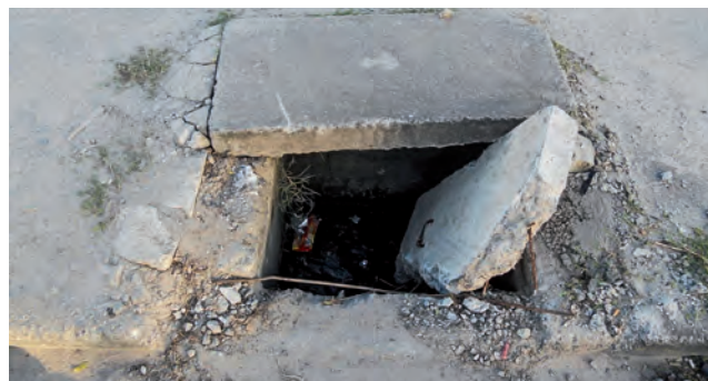
FIGURA 34 Galeria danificada.
