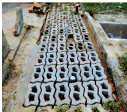
FIGURA 19 Colocação da camada de areia e dos blocos vazados no pavimento permeável da Escola de Engenharia de Pernambuco CTG/UFPE Dissertação de mestrado de COUTINHO, 2011.
