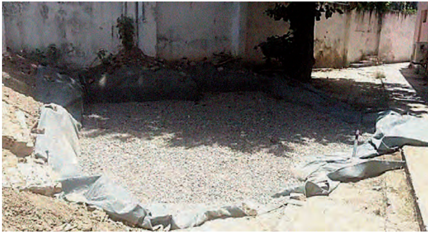
FIGURA 21 Escavação preenchida com agregado reciclado.
