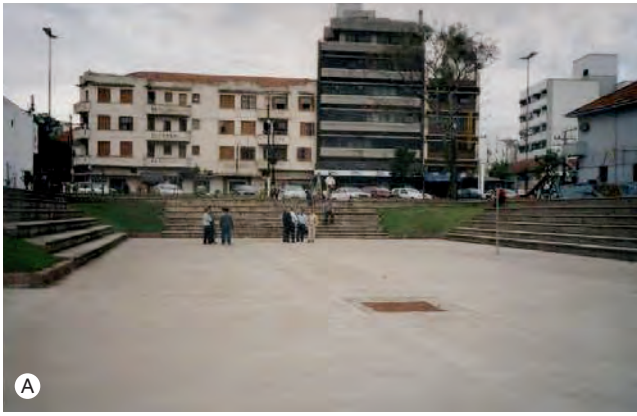
FIGURA 1 Bacias de retenção com usos de lazer e esportes nos dias sem chuvas intensas A) Porto Alegre, B) Grenoble (França).
