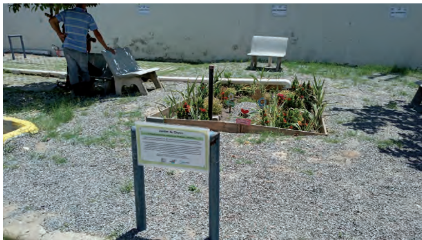
FIGURA 24 Jardim de chuva (sistema de biorretenção) construído no campus da Escola Politécnica da Universidade de Pernambuco. Dissertação de BARROS, 2021.
