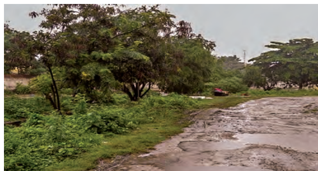
FIGURA 28 Canal do Cavouco: Margens não definidas.
