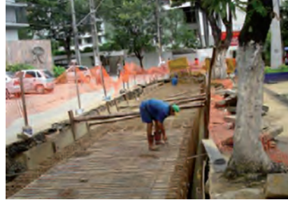
FIGURA 4 Detalhes da construção do microrreservatório na Rua Santo Elias, no bairro do Espinheiro, no Recife/PE.
