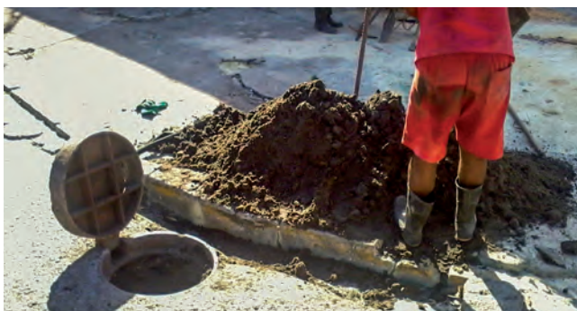
FIGURA 31 Limpeza de galeria.
