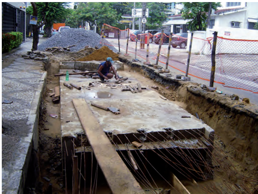
FIGURA 8 Reservatório de retenção da Rua Santo Elias em construção.
