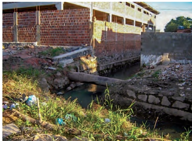
FIGURA 10 Travessia de tubulação com interferência, Rio Jiquiá.
