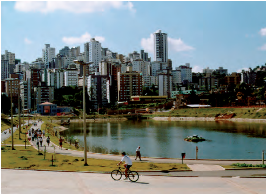
FIGURA 2 Lagoa de retenção em Belo Horizonte: além de ter a função de amortecimento das vazões, também é utilizada para atividades de esportes e lazer.
