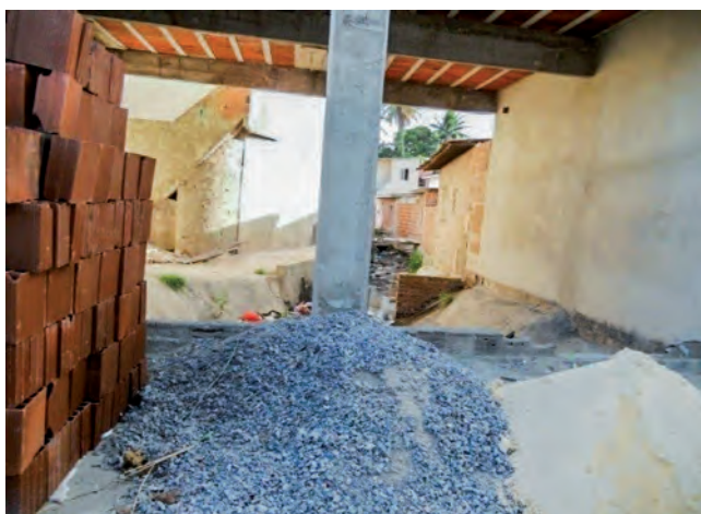
FIGURA 15 Casa erguida sobre o Canal de Guarulhos.
